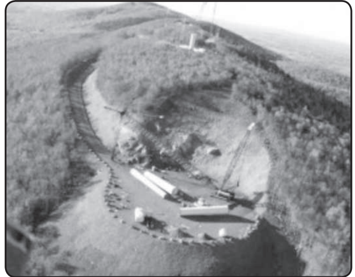
Wind turbine construction site Mars Hill, ME
